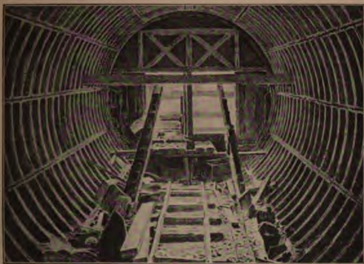
Fig. 156. — Vue de la galerie, du bouclier et des étais du boisage.
